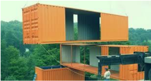
REFERENCIA: ESTRUCTURA DE CONTENEDORES MARITIMOS
